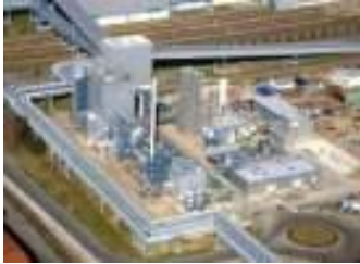
Vattenfall Schwarze Pumpe Germany - 30 MWth Oxy - Lignite
